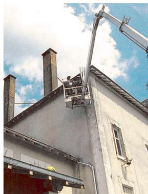
A l'école, côté cour, toutes les **descentes d'eaux pluviales** ont été remplacées par l'entreprise Hardy. Cette opération a nécessité la délicate mise en place d'une grue autotractée.
