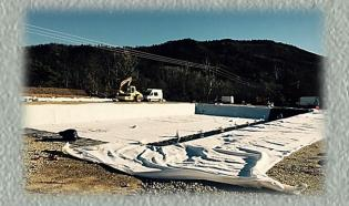
Les deux bassins ont été creusés puis recouverts d'une membrane étanche en « sandwich » entre deux géotextiles. Des drains de fond de bassin ont été installés puis des couches de matériaux de lestage ont été mises en place.
