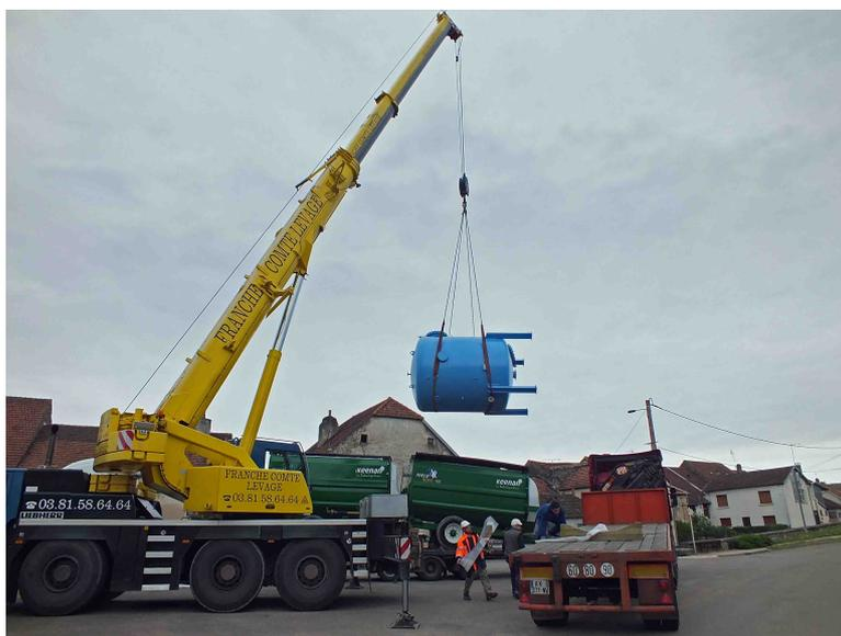
Un camion grue se chargea de transborder un énorme filtre à charbon actif d'une plate-forme de camion à une autre afin que celui-ci puisse, par un chemin forestier, apporter cet élément de purification de l'eau à l'intérieur de ce qui sera la future station de traitement de l'eau.
