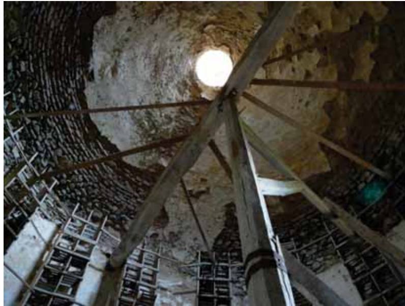
Document 35 : Détail toit intérieur du Colombier de Suzy
