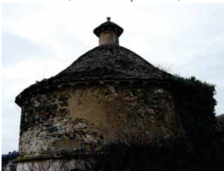
Document 33 : Détail toit du Colombier de Suzy (Vue Est)
