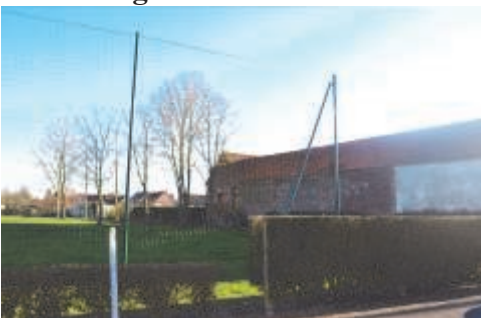
Pose de filet pare-ballon au petit stade, sur la D937
