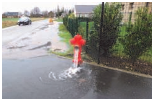
Mise en place de trois bornes à incendie rue de Brasserie
