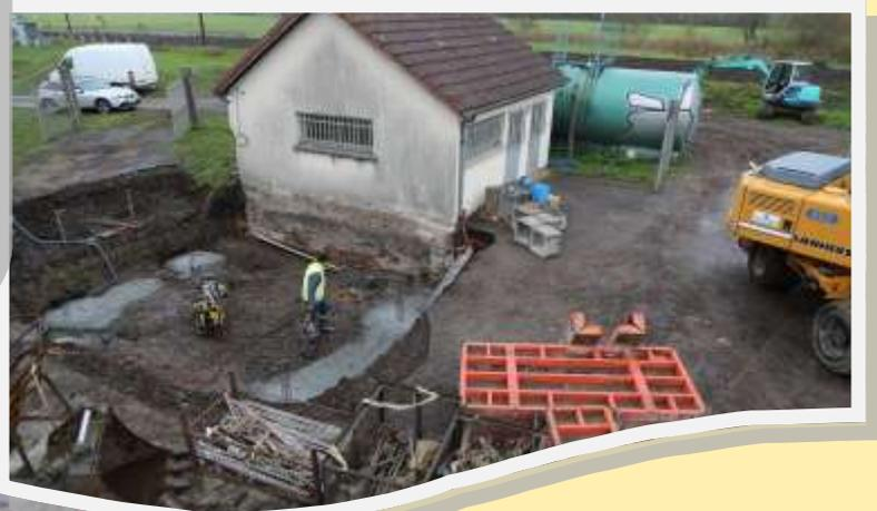
Le SIARE a engagé des travaux importants à la station de traitement des eaux, par l'installation d'une table d'égouttage des boues pour un coût de 400 000€
