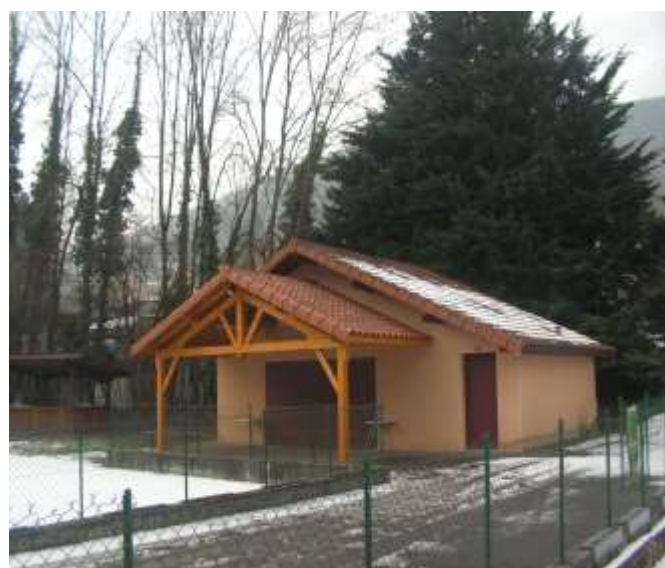
ESPACE BOULES 97 avec son avancée de toit réalisée en 2008
