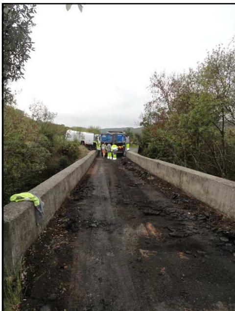
Après les vendanges, nous avons procédé au reprofilage complet du tablier du pont d'Escourbiau. Les travaux réalisés en une matinée par la société EIFFAGE ont permis de rendre rapidement le pont à la circulation.
