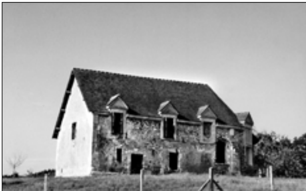
Goupillières - Ancienne chapelle Saint-Denis
