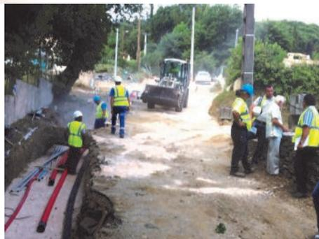
L'année 2012 s'achève sur 2 autres succès : le renouvellement de la canalisation de la source de l'Obavis, plus de 7 km de conduite qui nous permettent aujourd'hui d'être alimentés à 100% par nos propres captages et ainsi de ne pas alourdir notre facture en achetant de l'eau au Syndicat de l'Est.
