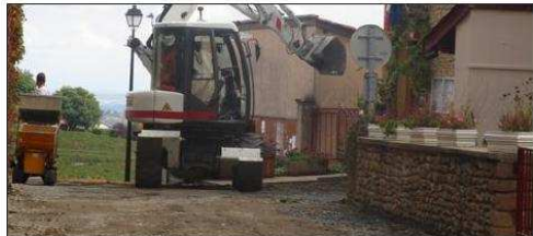
■ La rue de la mairie en travaux Photo Catherine LAPOSTOLET
