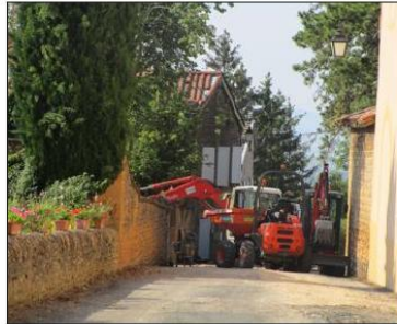
■ Suite aux travaux, la réfection est prévue pour la rue du sud et la rue de la mairie.
