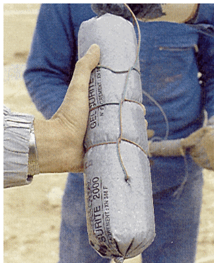
Mise en place des cartouches d'explosif
